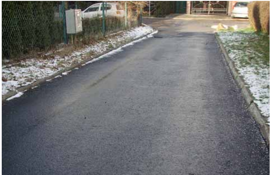
Nowa nawierzchnia ul. Siostry Zimmer
