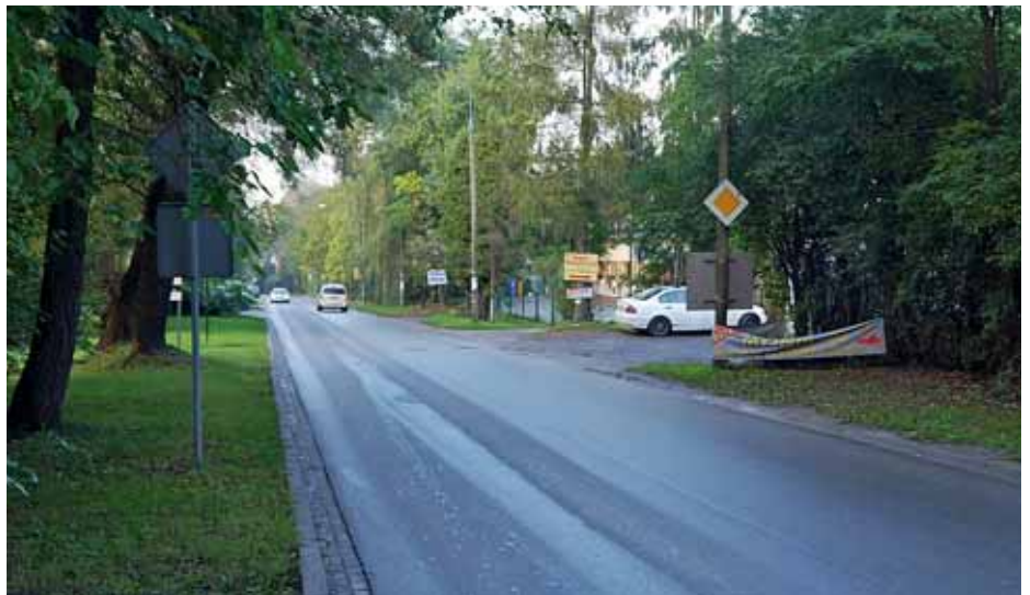
Ul. Borkowska z nowym asfaltem
