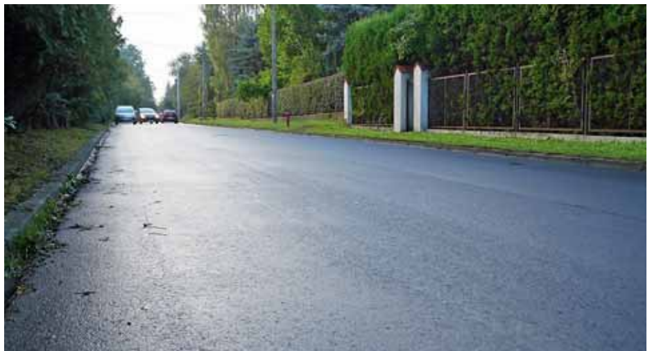
ul. Forteczna po remoncie
