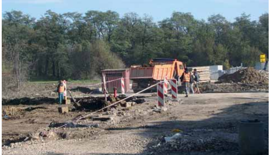
Budowa nowej ulicy, która ułatwi życie mieszkańcom osiedla przy ul. Mieczysławowej
