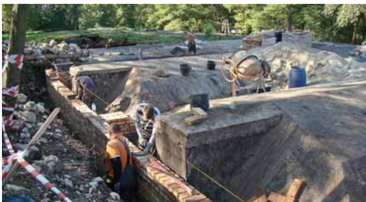
...obecnie trwa tu remont dachu nad dawnymi koszarami
