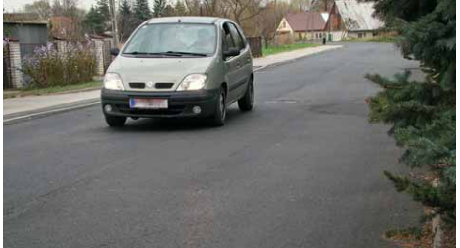
ul. Smoleńskiego z nową nawierzchnią i chodnikami
