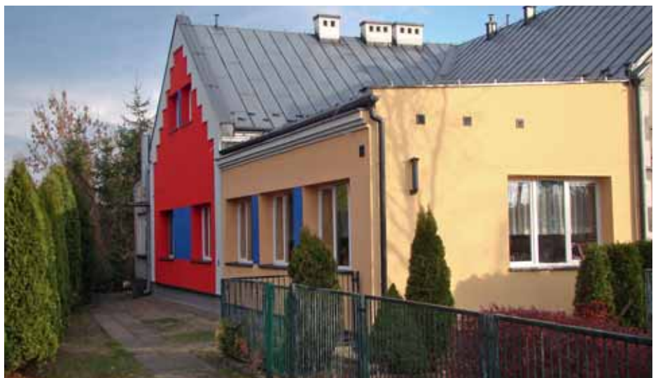
Kolorowa elewacja na budynku Przedszkola Samorządowego nr 145 przy ul. Poronińskiej
