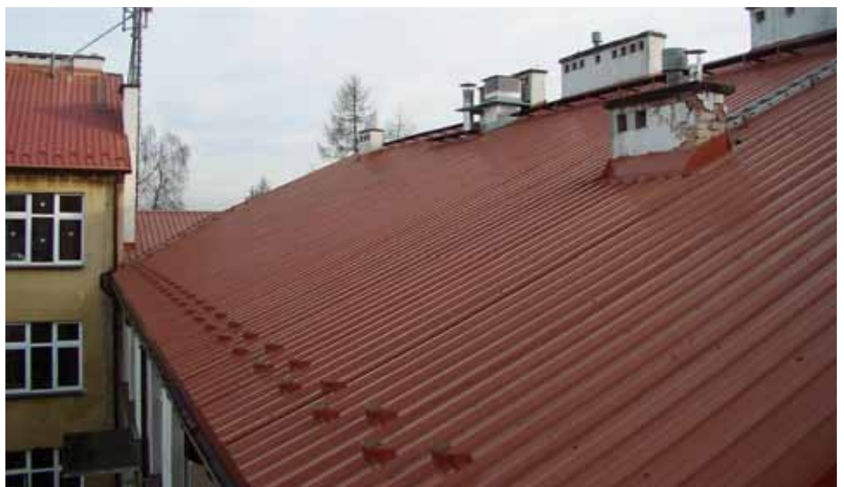
Fragment nowego poszycia dachu w ZSO 35
