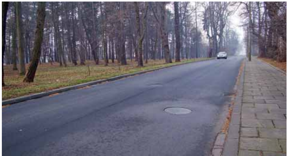
Ul. Kąpielowa po remoncie
