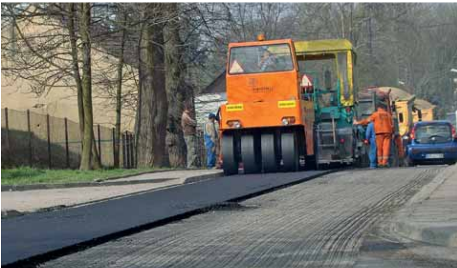
Ul. Merkuriusza Polskiego w trakcie remontu
