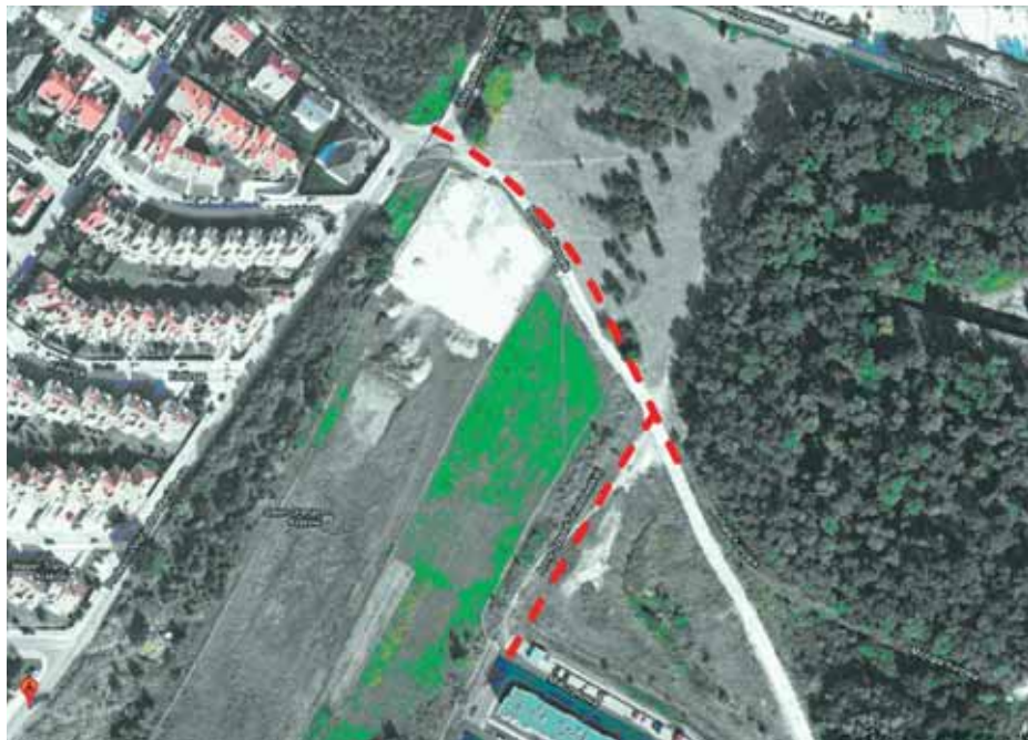
Tak właśnie mają przebiegać nowe odcinki ulic, łączących osiedle przy ul. Mieczykowej z resztą świata. Źródło: PRO-BUD.
